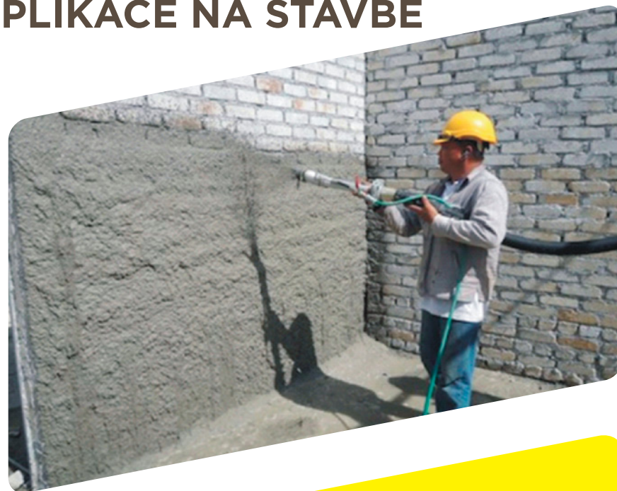
PFT SWING AIRLESS SWING L - s pistolí Graco a tryskou 651
