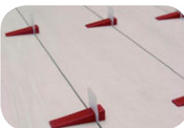
Ukázka zafixování a vyrovnaní velkoplošných keramických desek.
