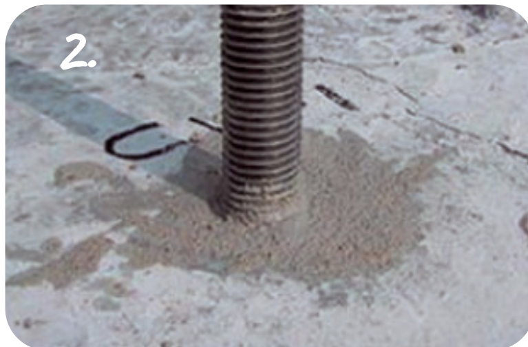
Betonáž závitové tyče
