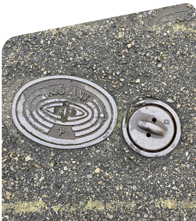
Usazení vodovod. ventilů
