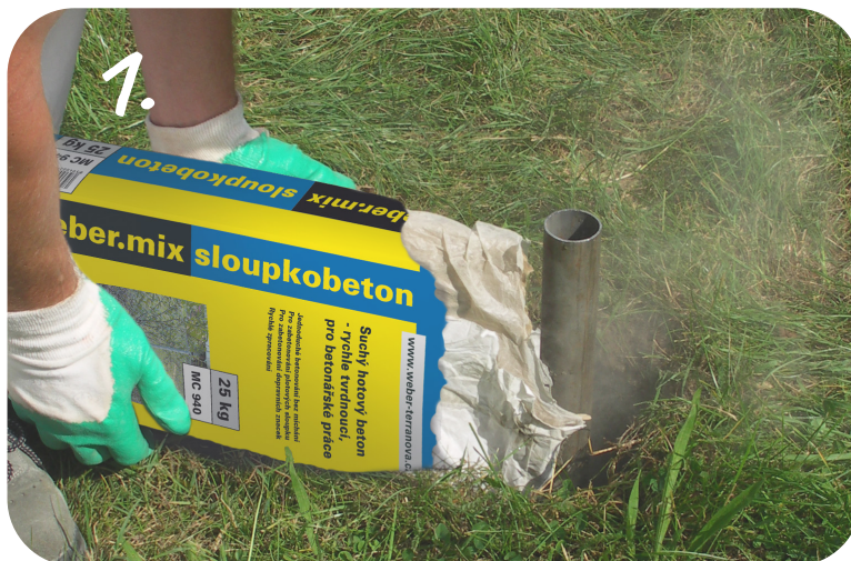
Zásyp otvoru suchou směsí
