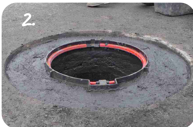
Osazování kanalizačního poklopu
