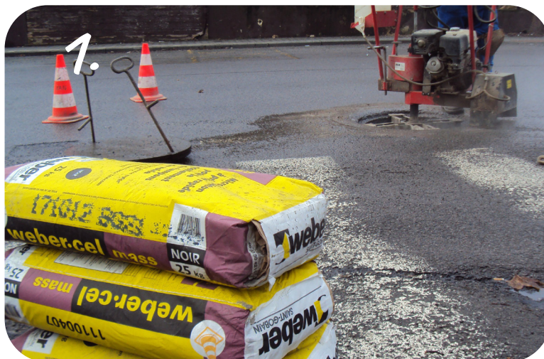
Oprava kanalizační šachty
