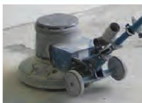
Je třeba odstranit i zbytky nátěrů, a to nejlépe škrabkou (u větších ploch obroušením nebo otruskáním). Pokud je povrch hloubkově narušen nebo znečištěn (oleje, rozpouštědla), je nutné ofrézování podkladu.
