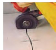
Příprava pro sešívání trhlin.
