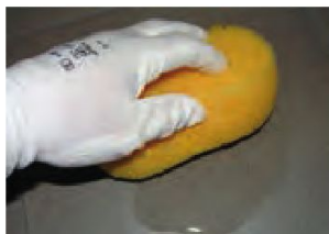
Starý nátěr je třeba odmastit např. saponátem s vodou a zároveň odstranit zbytky vosku alkalickým roztokem (soda + voda).
