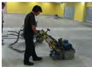
Na podlahách se používá metoda tryskání ocelovými kuličkami, broušení nebo frézování. Na stěnách, pilířích a průvlacích je možno provádět tryskání pískem.
