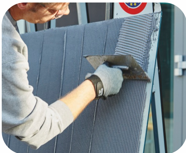
Nanesení lepicí hmoty weber.therm style Klebemörtel 2K zubovým hladítkem s trojúhelníkovým zubem.
