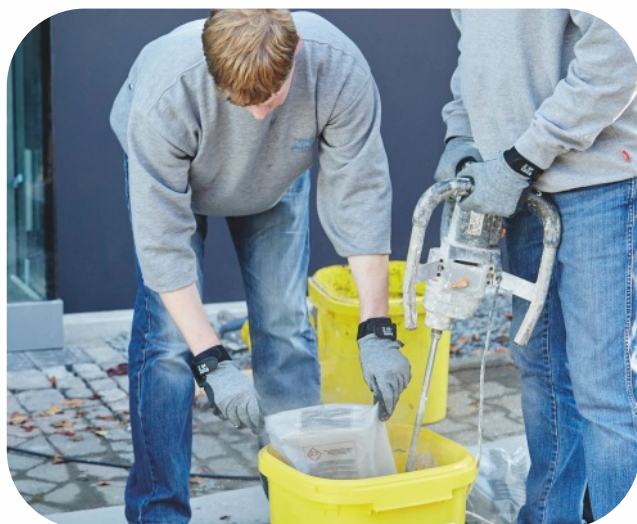
Příprava lepicí hmoty weber.therm style Klebemörtel 2K . Prášková složka se smíchá ve vědru s tekutou složkou.
