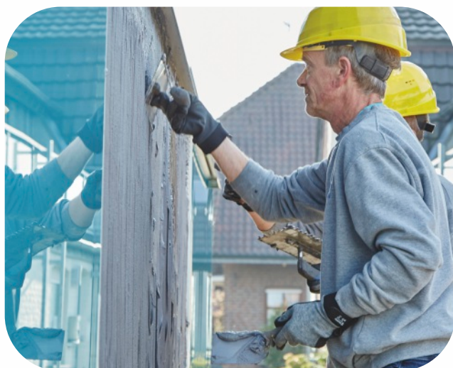
Nanesení lepicí hmoty weber.therm style Klebemörtel 2K na podklad hladkou stranou hladítka.
