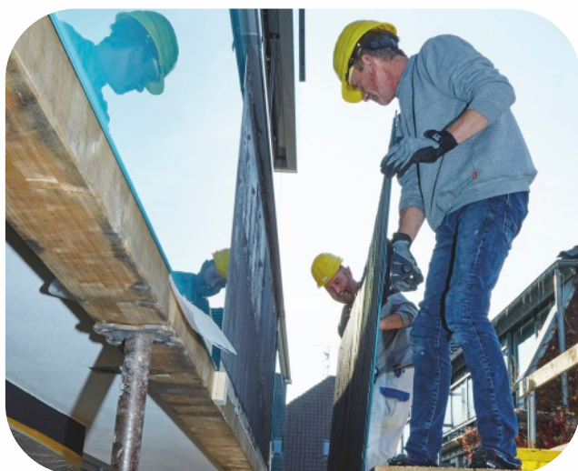
Přilepení skla s lepicí hmotou weber.therm style Klebemörtel 2K na podklad s naneseným lepidlem.
