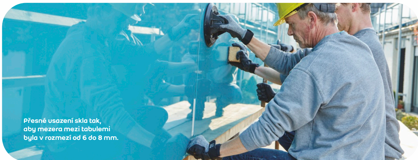
Přilepení skla s lepicí hmotou weber.therm style Klebemörtel 2K na podklad s naneseným lepidlem.
