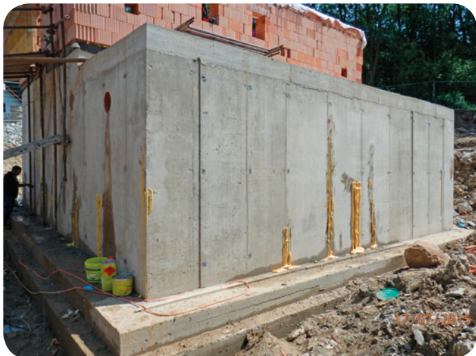
ČOV Tašov použité materiály: weber.tec imper F, weber.tec 944
