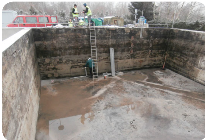
ČOV Velké Losiny použité materiály: weber.rep vysprávka, weber.tec imper F, weber.tec 944, weber.sys epox nt
