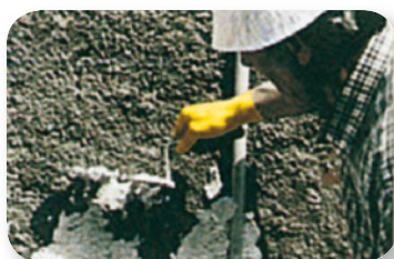
sanace vlhkého a zasoleného zdiva
