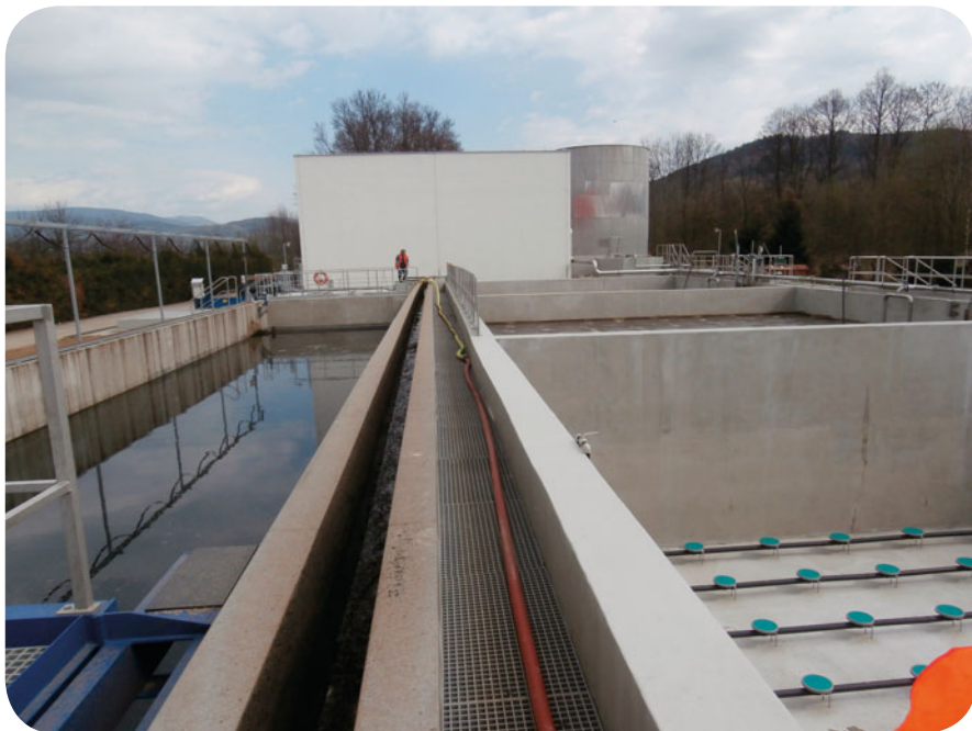
ČOV Velké Losiny použité materiály: weber.rep vysprávka, weber.tec imper F, weber.tec 944, weber.sys epox nt
