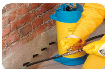
dodatečné vodorovné hydroizolace u vlhkého zdiva
