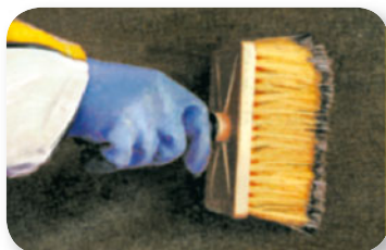
hydroizolace proti zemní vlhkosti bez nutnosti použití natavovacích pásů
