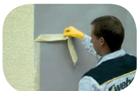
pracovní spáry v případě, že z jakéhokoliv důvodu nemůžete provést celou plochu najednou,
