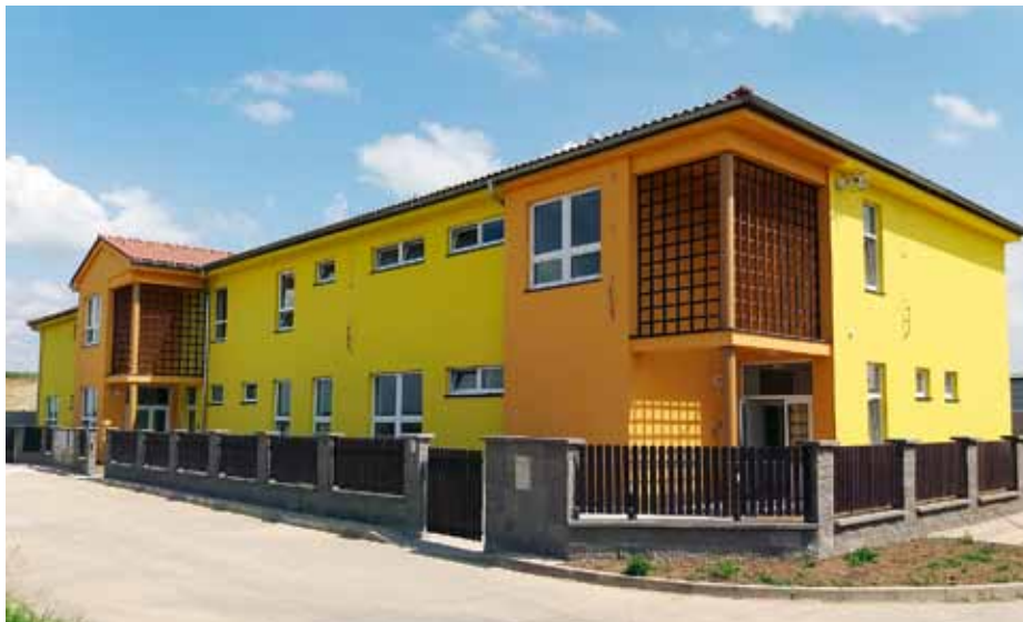
Novostavba Základní školy v Šestajovicích
