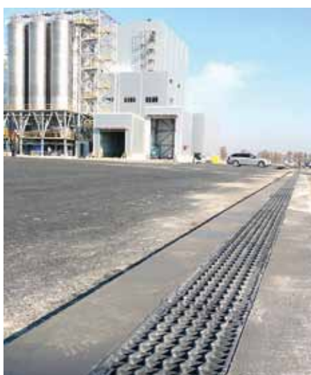
Odvodnění ploch u výrobního závodu Nexen v Ústeckém kraji. Bylo zde položeno 960 m kompozitních žlabů MEARIN Expert pro komunikace, které mají vysoké nároky na provoz, údržbu a zátěž (až E600 kN) v šířkách 100, 150 a 200 mm.
