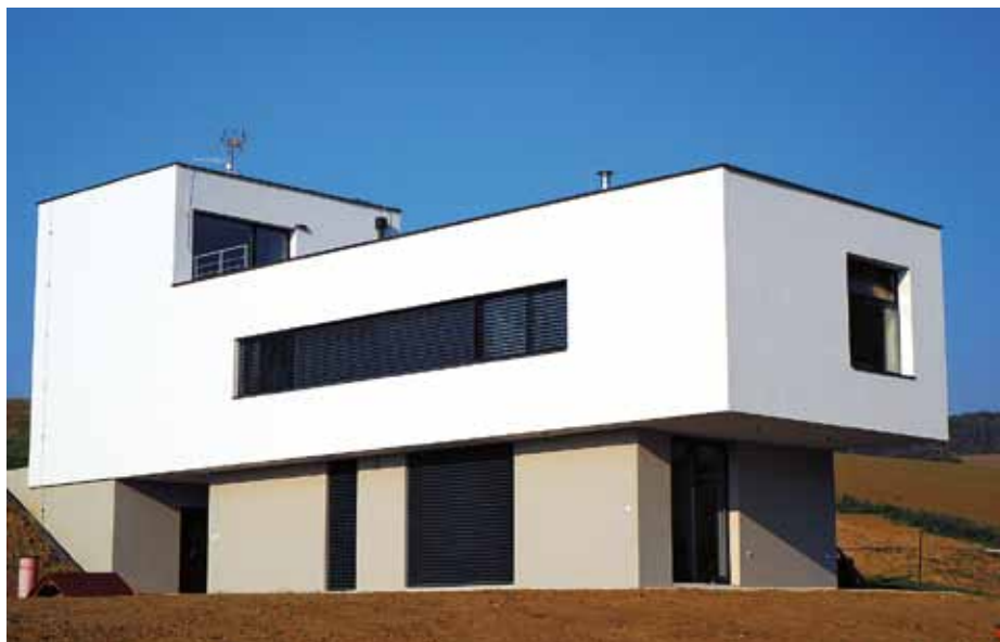
Novostavba rodinného domu – zateplovací systém Baumit open, Baumit NanoporTop, Baumit CreativTop
