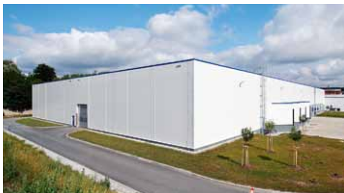
Logistická hala SAHM, Heřmanova Huť
