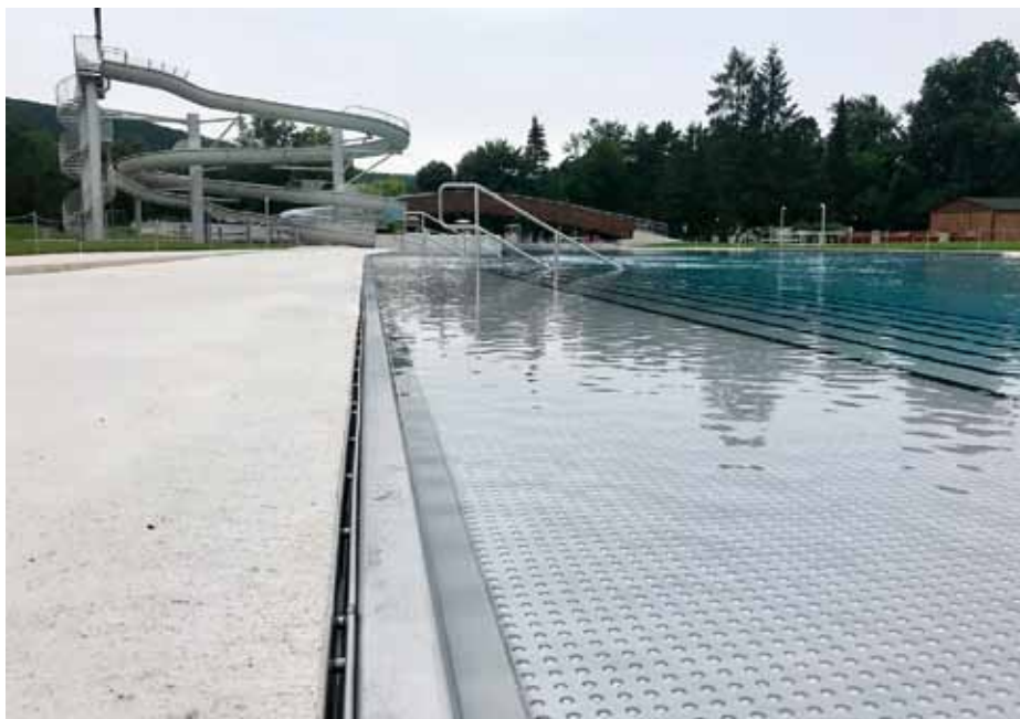
Rekonstrukce brněnského koupaliště Riviéra. Odvod dešťových vod tvoří nerezové šěrbinové kryty MEA TSH 100, které jsou umístěny mezi chodníky z betonu a bazénovou vanu s délkou 650 m. Pod povrchem jsou rozšířeny a posazeny na sběrný kanálek z polymerbetonu.
