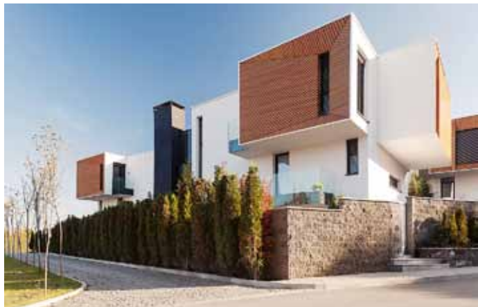
Novostavba rodinného domu – zateplovací systém Baumit Star, Baumit NanoporTop
