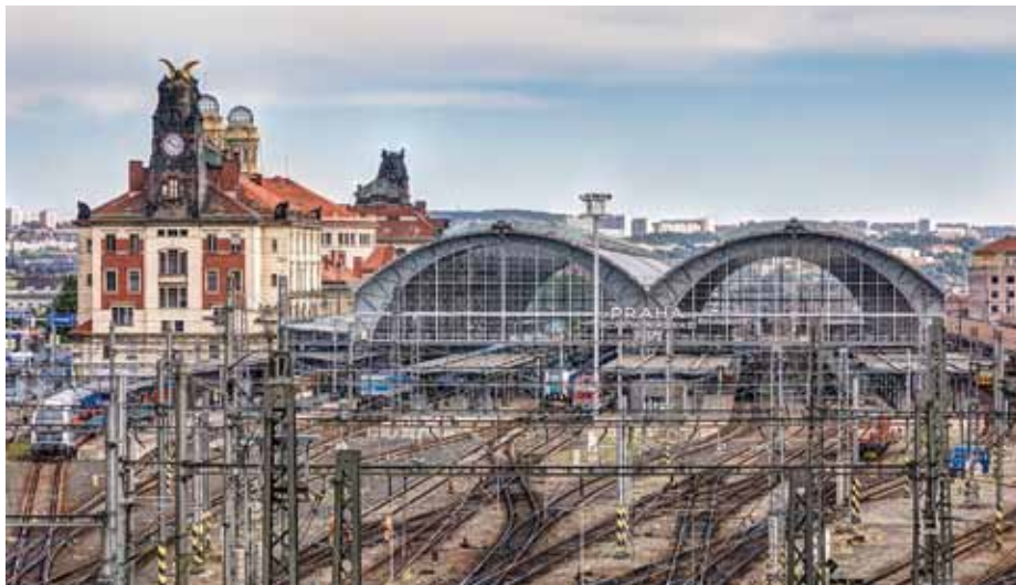
Rekonstrukce zastřešení haly žst. Praha hlavní nádraží
