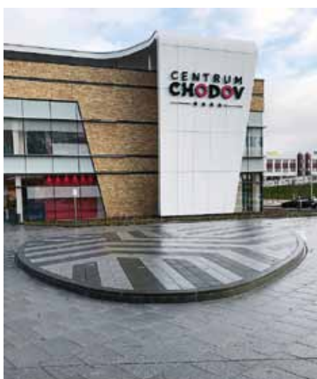
Estetické a funkční odvodnění ploch u nákupního centra OC Chodov Praha se systémem šěrbinového odvodnění MEA TSH v sobě spojuje odvodňovací žlab, který je skrytý v dolní části konstrukce, a kryt, ze kterého je na povrchu vidět pouze úzká, téměř neviditelná spára.
