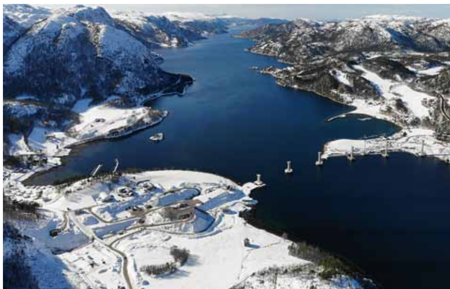
Most přes fjord Astfjorden v Norsku, který je spolu se dvěma tunely součástí přeložky silnice
