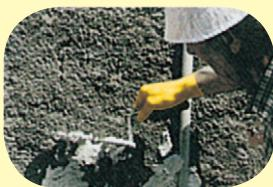
**Weber.san super** se nahazuje na předem nahozenou první vrstvu v tloušťce 5 – 10 milimetrů vytvořenou z omítky **weber.san super**. Po nahození této vrstvy počkáme na její zavadnutí 2 – 4 hod, dle teploty a savosti. Při vysoké mříži zasolení doporučujeme dodržet techn. přestávku 24 hod.
