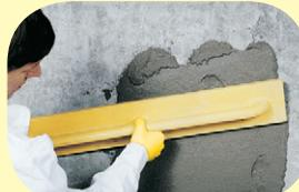
Povrch druhé vrstvy omítky můžeme strhnout latí a upravit velkým průjazvým hladítkem. Sanační omítka se ukončí cca 20 mm nad terénem v celé tloušťce.
