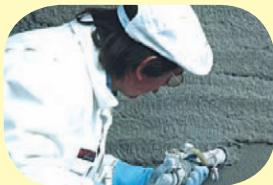
Minimální tloušťka následné vrstvy po postřiku musí být 10 – 15 mm tak, aby celková tloušťka dosahovala všude minimálně 20 mm. Optimální vrstva je 30 mm. Vrstvy nad 30 mm je nutné provádět tzv. vrstvením. Omítku nestlačovat!
