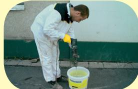
Hmota se připraví postupným vmícháním jednoho pytla omítky do cca 4,8 l čisté vody pomocí unimixeru, kontinuální mísicího s provdůšňovacím tubusem, případně se nanáší pomocí strojní omítáky s provzdúšňovacím ventilom.
