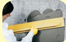
Sanační omítka **weber.san sanační WTA** se nanáší v min. síle 20 mm (při prvním použití) a 10 mm při použití **weber.san vyrovnávací WTA**. Při větších vrstvách než 30 mm, se nanáší vícevrstvě, přičemž každá předchozí vrstva musí být řádně zdrsněna a vyschlá (viz technologie nanášení). Na závěr se stáhně a zarovná latí. Sanační omítkový systém se ukončí cca 2 cm nad terénem v celé tloušťce.
