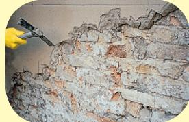
Původní vlhká a zasolená omítka se odstraní s přesahem minimálně 1 m nad hranici vlhkosti. Spáry ve zdívě se vyškrábou, houbovitá a rozpadlá zdivo se odstraní. Okopaný materiál ihned odstraní z pracovní zóny. Vzniklé otvory očistit a znova vyzdíti. Nakonec je nutné celou plochu, která má být opatřena podkladním podhodem, očistit důkladně kartáčem.
