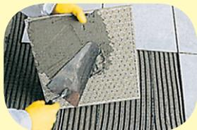
Doporučujeme lepit způsobem oboustranného lepení – tzn.: Na dlaždicí se nanese vrstva lepidla 1–2mm s ilná.
