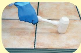
Po osazení dlaždice do lepidla poklepeme plastovou paličkou stabilizujeme dlaždicí a vytlačíme vzduch. Spárovací maltu aplikujeme po 6 hodinách.
