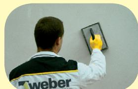
Úprava povrchu se provede molitanovým nebo houbovým hladítkem.
