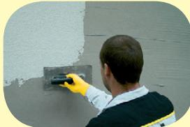
Natahování omítky se provádí nerezovým hladítkem v tloušťce do 2 mm.
