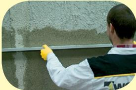
**weber.dur klasik RU, JRU** – doporučená tloušťka jedné vrstvy je od 10 mm do 25 mm. Při větších tloušťkách omítky doporučujeme aplikaci ve dvou vrstvách. Nanášení druhé vrstvy se provádí na čerstvou zavadlou první vrstvy. Nanesená omítka se zarovná do roviny strhávací latí.
